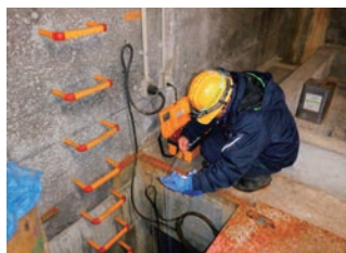
アンダーパス排水設備の高圧洗浄・清掃
