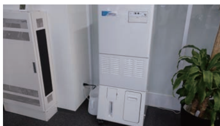
1階・2階事務室へ多機能加湿器導入
