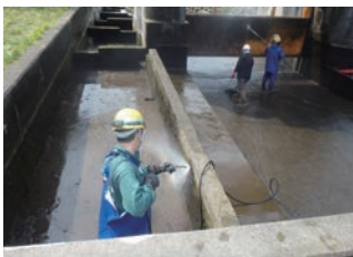
河川の高圧洗浄作業を実施
