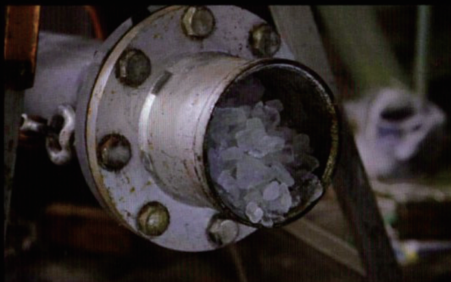
濃縮汚泥配管に氷を注入(地下)
