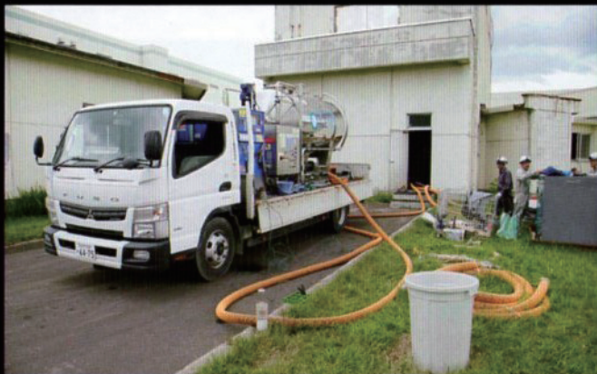
配管内にアイスシャーベットを注入(地上)
