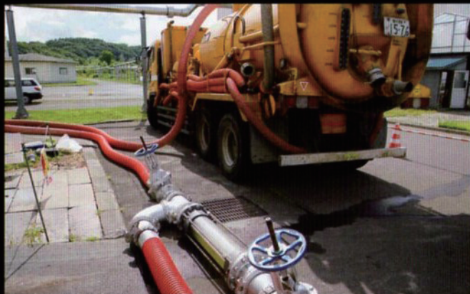
配管内の堆積物を回収するバキューム車(地上)
